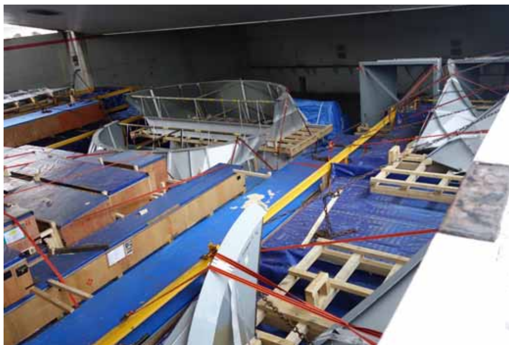
圖3.14 | 裝滿預裝配鋼製品的貨艙。
