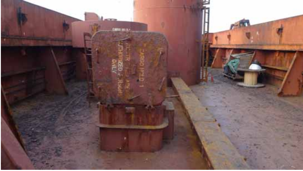
圖2.11 | 貨艙出入艙口處於不良狀況。
