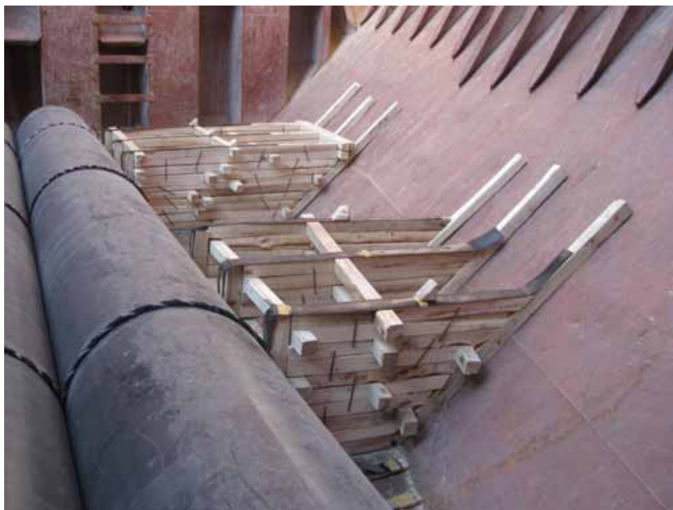
圖4.5 | 在斜邊艙內建造墊艙結構物，使大直徑鋼管保持原位。
