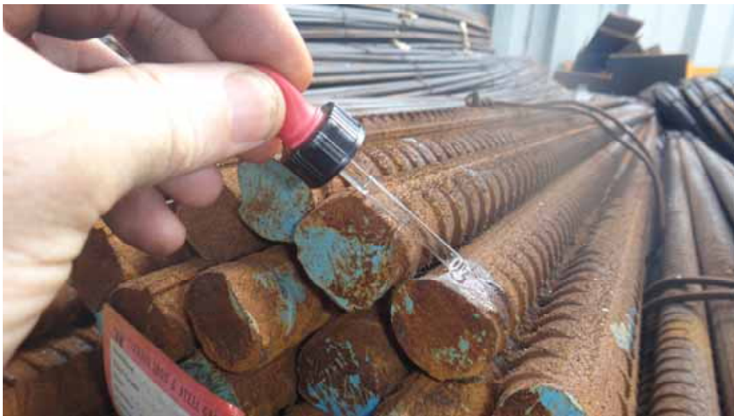
圖8.1 | 對使用鋼絲捆紮的鋼筋進行硝酸銀試驗。
