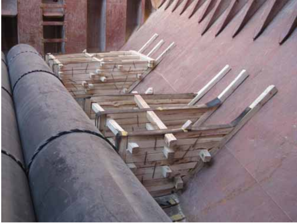
图4.5 | 在斜边舱内建造垫舱结构物，使大直径钢管保持原位。
