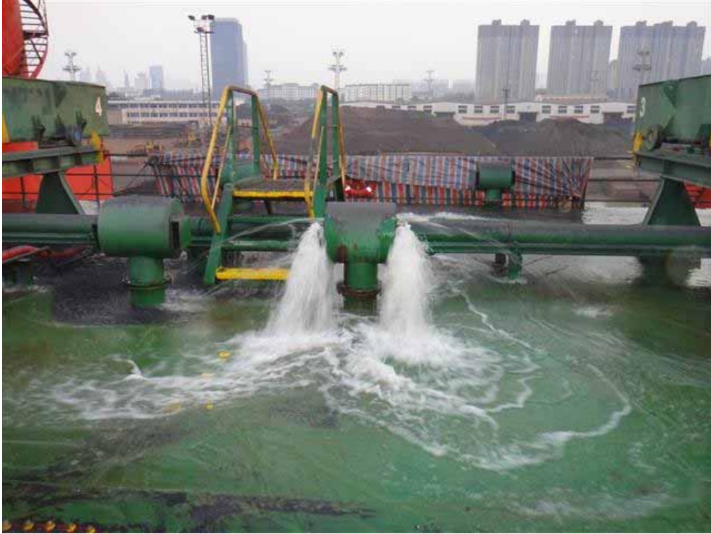
图2.8 | 压载舱水压试验。
