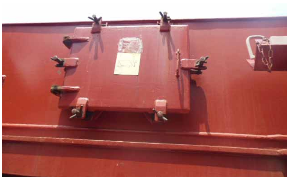
图2.7 | 舱盖板侧面的通风舱口。
