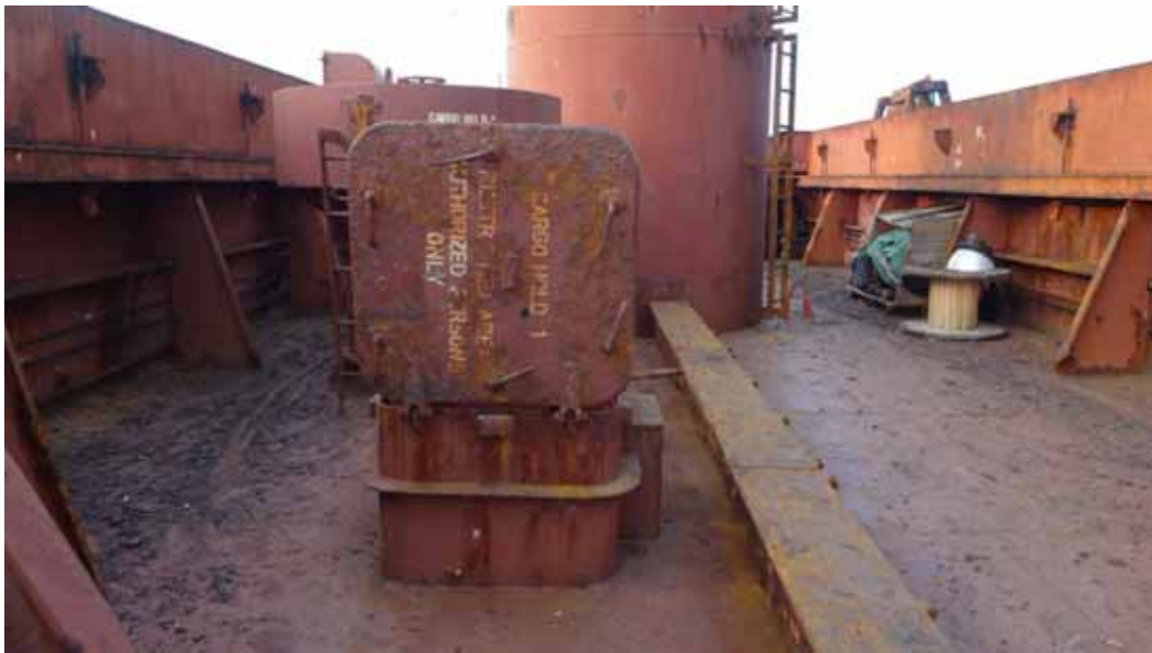
图2.11 | 货舱出入舱口处于不良状况。
