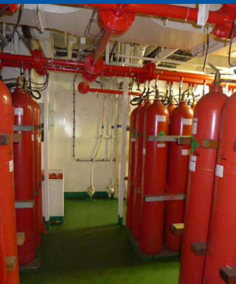
轮机长迅速行动，与船长交谈，二人商定使用固定二氧化碳系统灭火。意识到情况紧急，轮机长和第二见习轮机员迅速确认没有人员滞留在机舱。其后，轮机长迅速打开了二氧化碳系统。正如所料，二氧化碳延时警报响起，机舱通风扇随着二氧化碳延时警报响起而停止。不久之后，他们听到二氧化碳气瓶释放二氧化碳。
